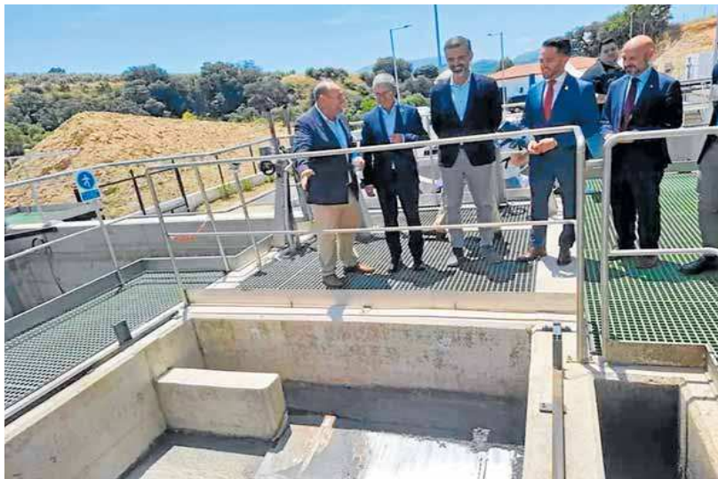
Inauguración de la depuradora de aguas residuales en Arriate. sur
