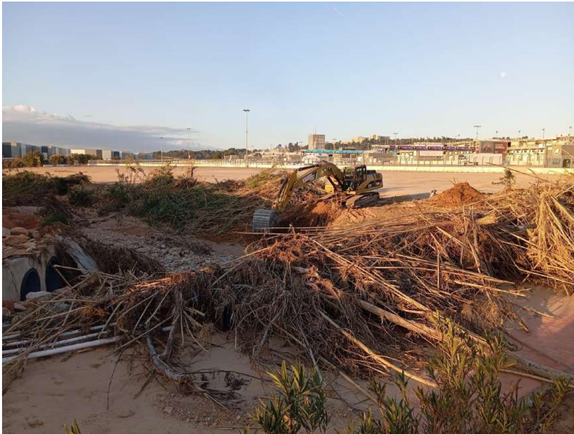
Imagen de cómo quedó el puente y los accesos al Circuit Ricardo Tormo de Cheste dañados por la dana
